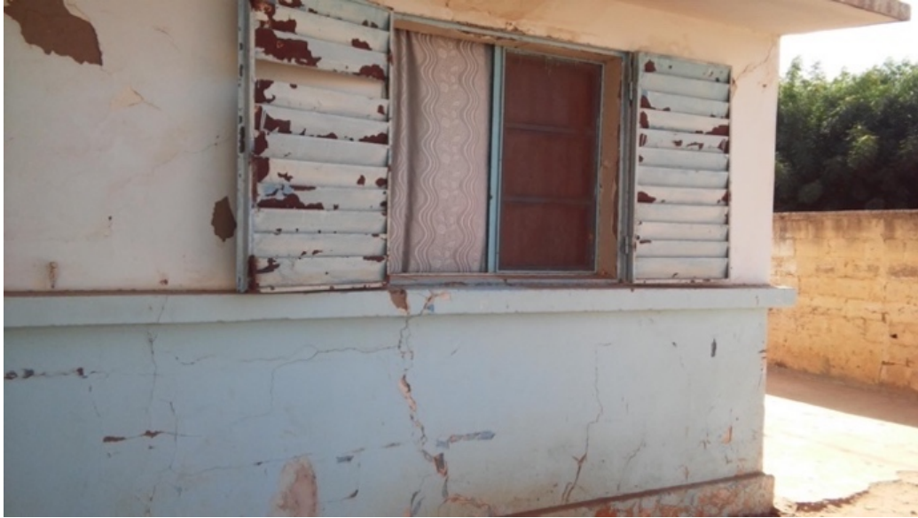
Photos du centre de santé de Thilogne pré-rénovation (décembre 2016)
